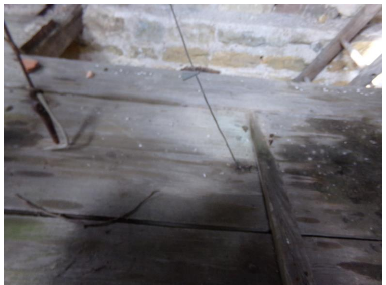
câble de tirage du marteau de tintement
